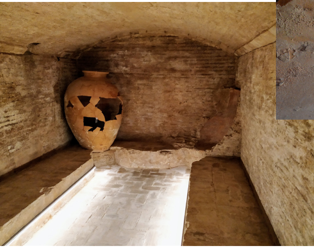
Tenalles del celler restaurades. Foto: Bence Kòvacs.
