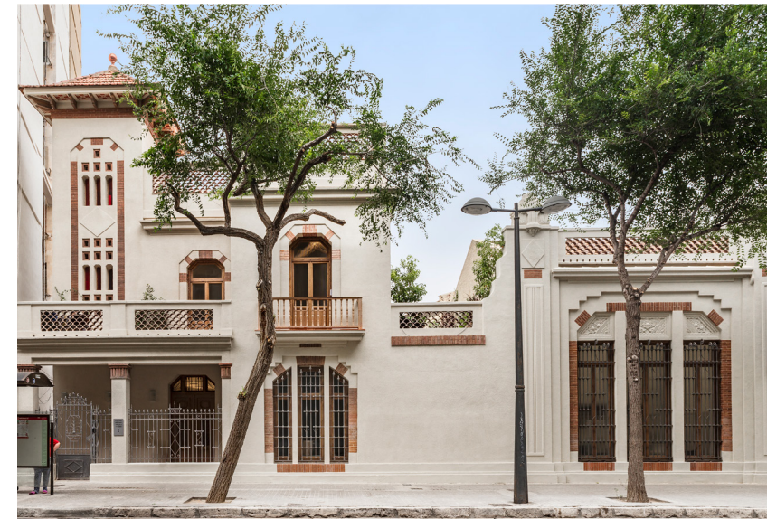
Façana del pavelló de residència de l'encarregat i el guarda de la fàbrica de Bombas GEYDA. Foto: Frank Gómez.
