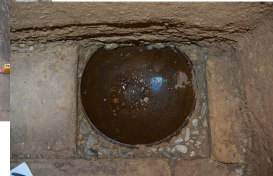
Basseta per a la neteja del celler i llibrell incrustat a la base. Fotos: Paloma Berrocal Ruiz.
