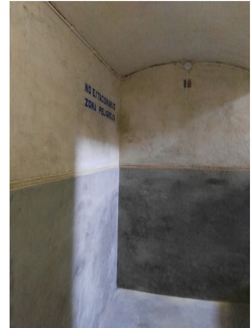
Detall de l'interior del refugi.
