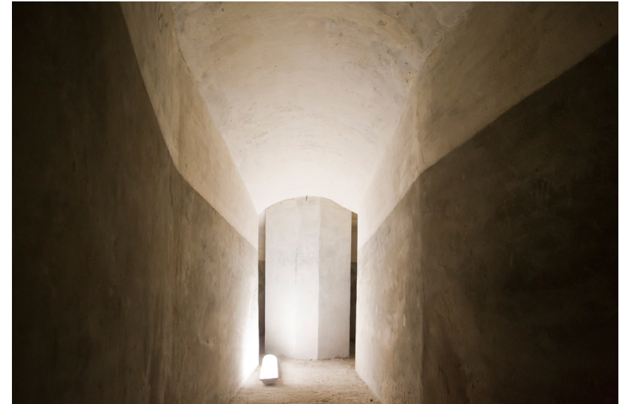
Pilar central en el corredor d'eixida del refugi de Bombas Gens. Foto: Daniel Rueda.
