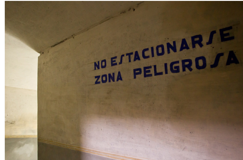
Antesala o replanell en el qual acaben les escales de l'entrada. Ací el corredor gira en un angle de 45° abans de dirigir-se cap a la sala principal. Foto: Paloma Berrocal Ruiz.
