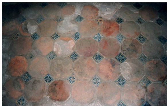
Paviment de roses gòtiques del saló de l'alqueria. Foto: Víctor M. Algarra Pardo.
