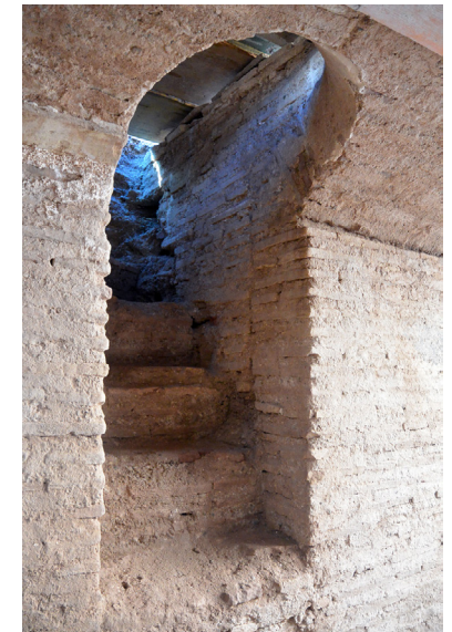
L'escala d'accés al celler una vegada alliberada de terra i derrocs. Foto: Paloma Berrocal Ruiz.
