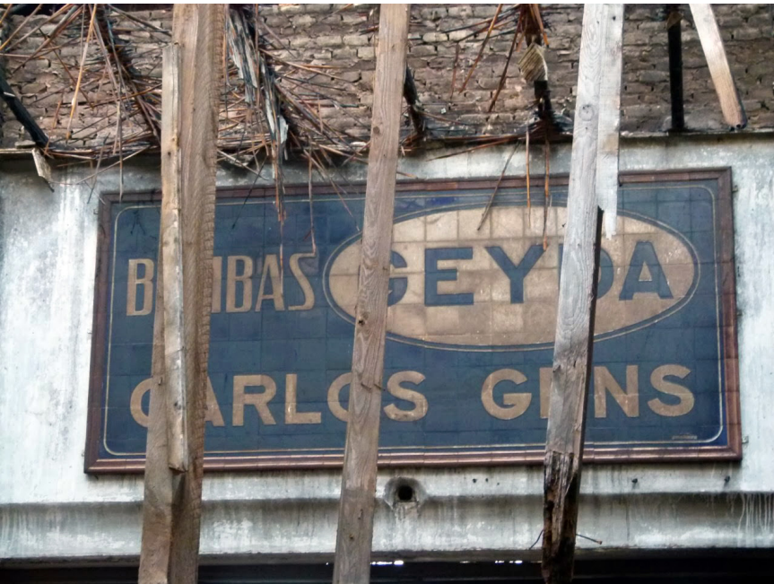
Panell publicitari de Bombas GEYDA en la ubicació original. Estat inicial abans de la intervenció. ©Cercle Obert.
