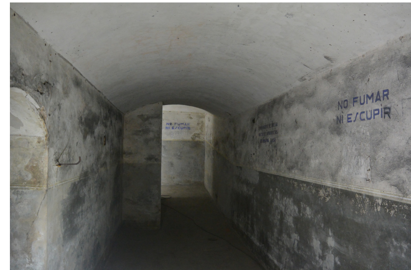
Vista general del refugi abans de la intervenció.
