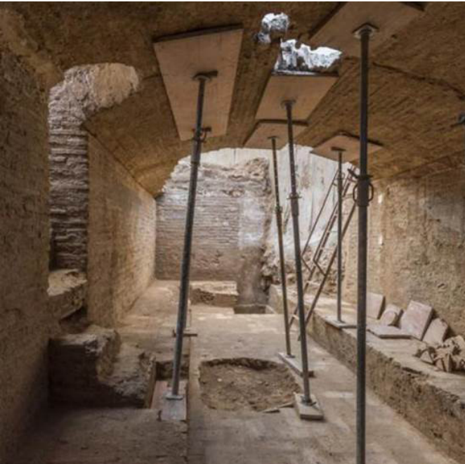
Estat del celler al començament dels treballs de restauració.
