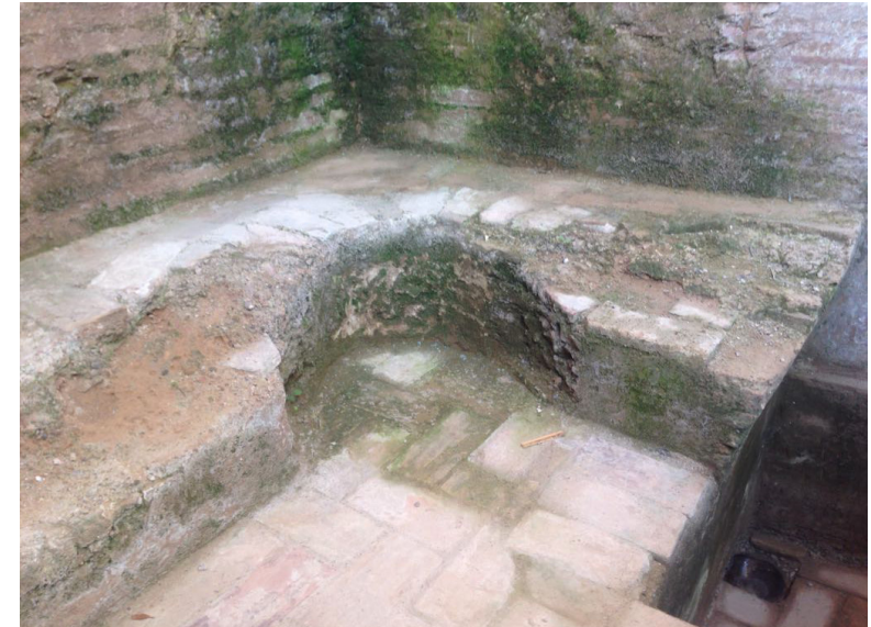
Proliferació biològica i absència de rajoles i morter en part del banc.
