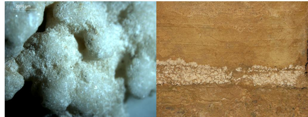
Recristalización de sales, seguramente sulfato de calcio. Especialmente presente en el arranque de la bóveda. En el detalle de un fragmento de sulfato de calcio, extraído de las sales precipitadas, observamos, a modo de estalactita, una presencia continua de humedad provocada por un goteo lento y prolongado que deriva en la formación sales insolubles.
