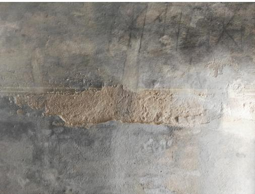
Manchas de carbonatación de sales, disgregación de estratos y estratos de recarbonatación en superficie.
