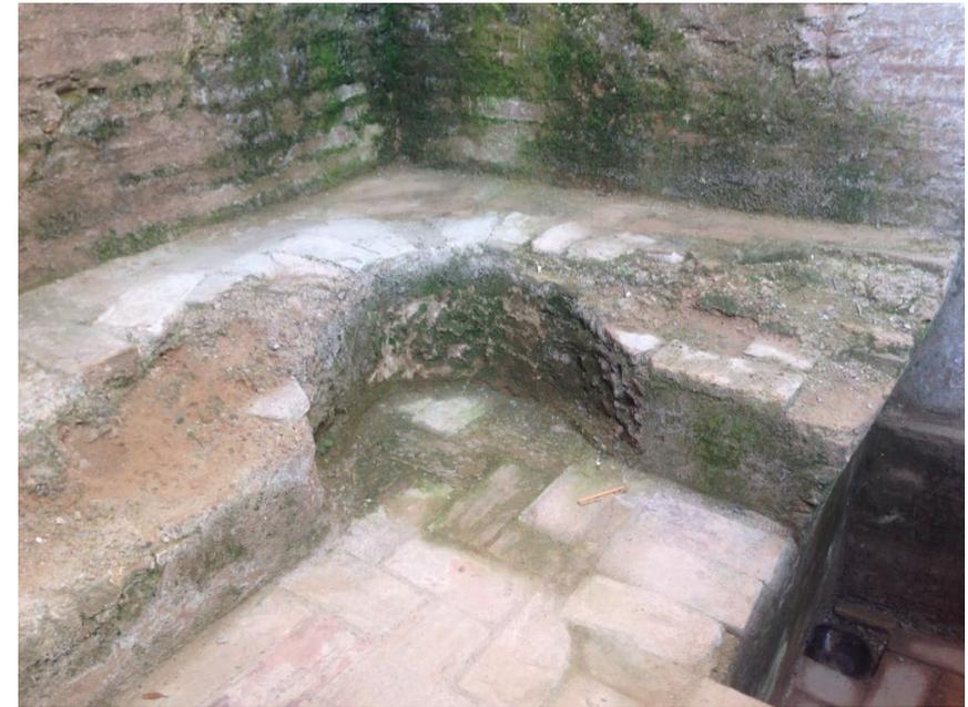
Proliferación biológica y ausencia de ladrillos y mortero en parte de la bancada.
